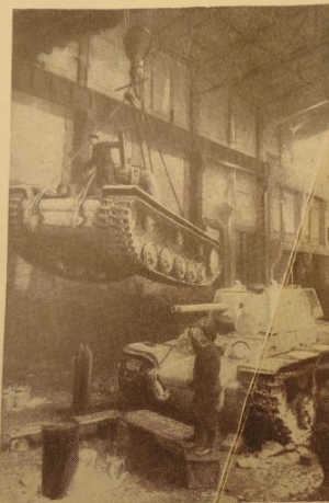
В восстановленном цехе И-ского завода идет ремонт танков.
