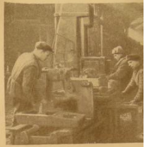
Установка оборудования в механ. восстанавливаемого И-ского
